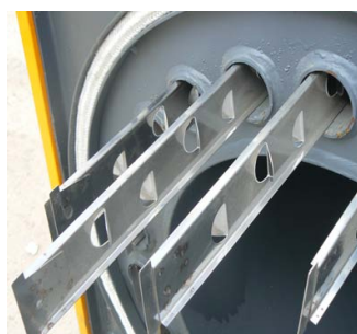
Zawirówki spalin poprawiają sprawność kotła
