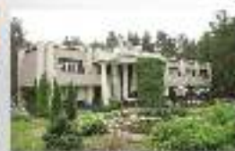
Obiekt WAF, 350 kW
